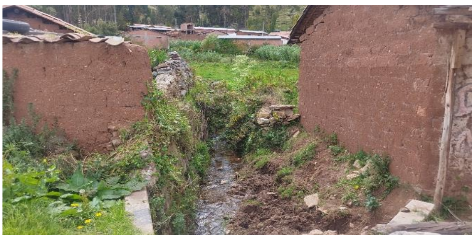
FIGURA N° 02: SE APRECIA EL CAUCE DELA QUEBRADA THUMI COLMATADO Y ESTRANGULADO, ASI MISMO EXISTE VIVIENDAS Y SEMBRIOS ALEDAÑOS AL CAUCE EN AMBAS MARGENES DE LA QUEBRADA .
